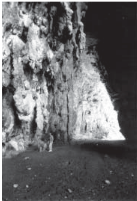
Fig. III: Galeria-túnel do Morro Furado.
