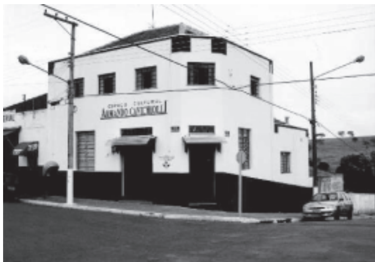
Foto 1: Fachada do Centro Cultural Armando Cavichioli e Museu do Índio de Iepê, Município de Iepê, SP, após restauração Fotografia: Neide Barrocá Faccio (2000)
